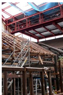
工事が進む草野家
