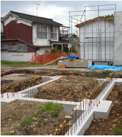
建設中の倉庫と収納庫の基礎部分
