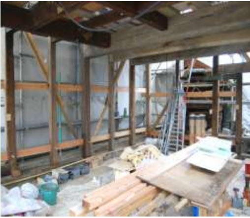
伝統工法に拘って修理が進む柞原家土蔵
