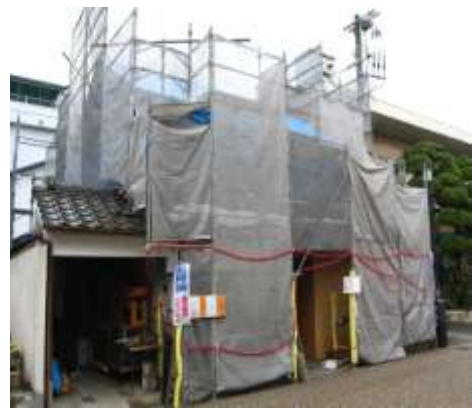
足場が組まれ、修理が進む坂本家
