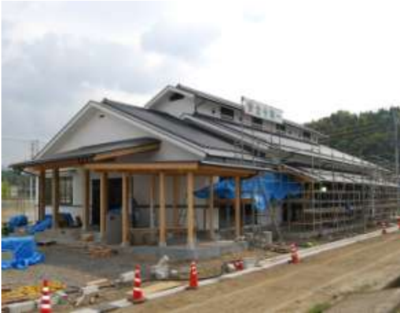
外観がほぼ完成した桂林公民館
