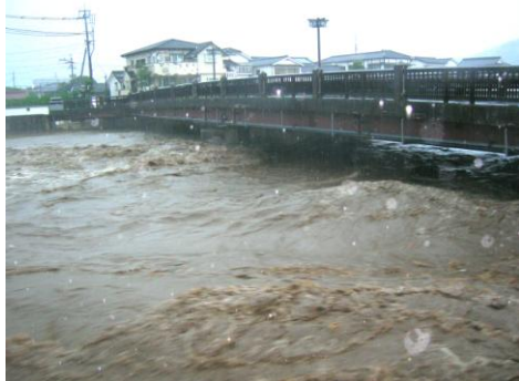
橋げたを超え増水した花月川
