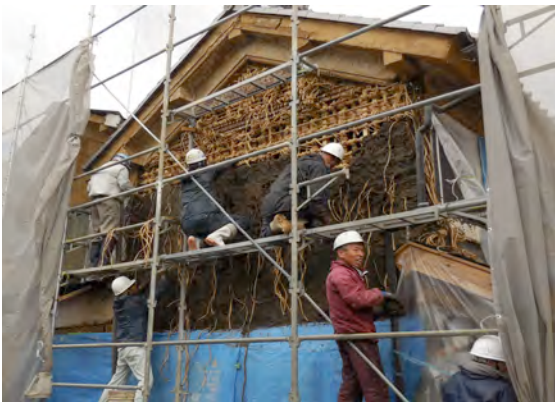
壁を昔ながらの工法で修理する水田金物店
