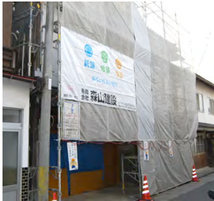
修理が始まった田嶋家
