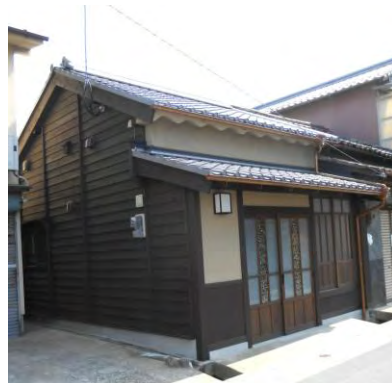
横壁を板張りにし、前面も木製硝子障子に修景した小野家
