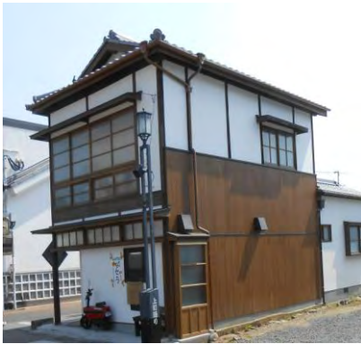
建築当時の写真を基に、修景を行なった梅山家
