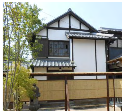
軟弱地盤を補強しながら完了した岩尾家座敷
