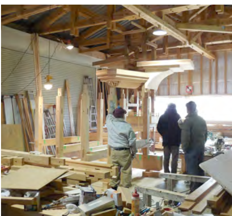
組立てが進む上町山鉾の作業現場
