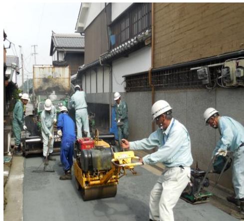
舗装工事が行われ、美装化完了
