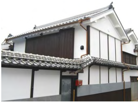
修理工事が終了した水田家西棟
