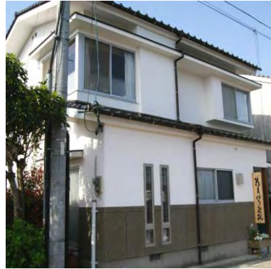
外壁工事が終了した光永家
