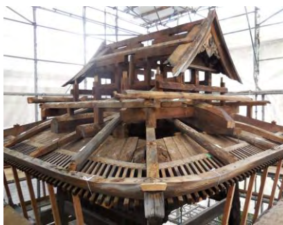
屋根瓦を取り外し、部材 の傷み具合を点検、修理 が進む長福寺の鐘樓
