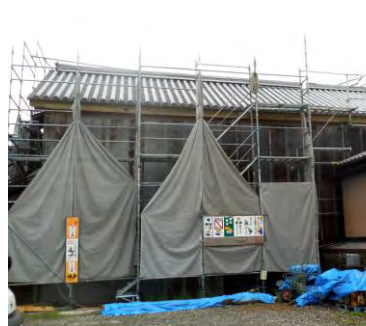
屋根瓦の葺き替え工事も 終了した薫長酒造穀蔵の 修理現場
