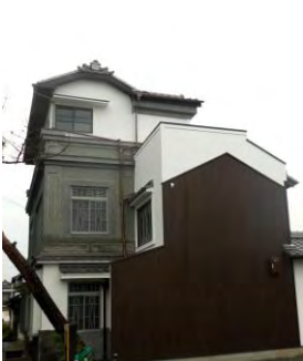
外観工事が終了し、 工事用覆いが取れた旧船津歯科
