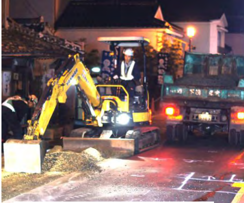
夜間行われた補修工事の写真
