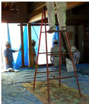
耐震補強工事を含め修理工事が進む離れ座敷
