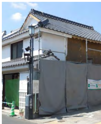
柞原家主屋の修理現場
