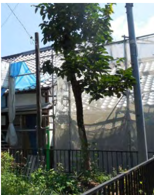
小倉家長屋の修理現場
