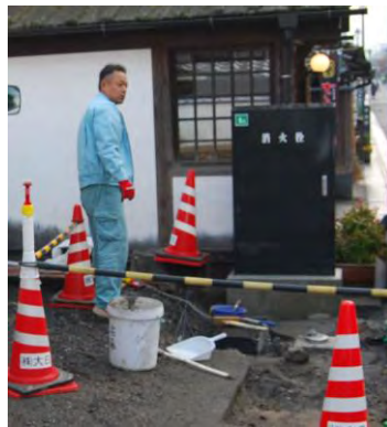
水道管敷設後、屋外消火栓設置工事が行われる。
