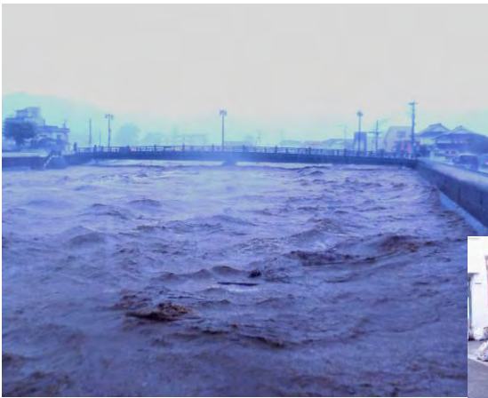
一新橋の橋脚すれすれまで増水した花月川
