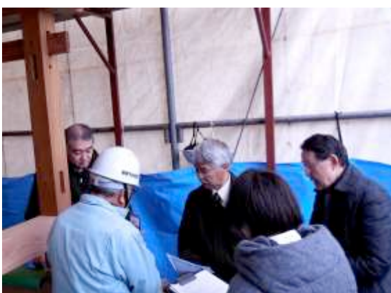
作業の進捗状況を確認する伊東・段上の両先生
