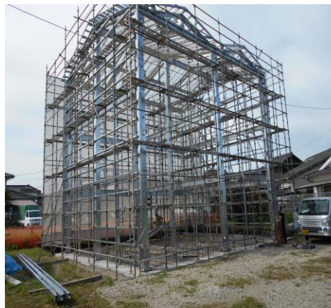
建設が進む山鉾収納庫
