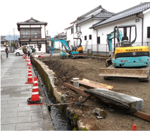
工事が進む豆田上町の小公園整備事業
