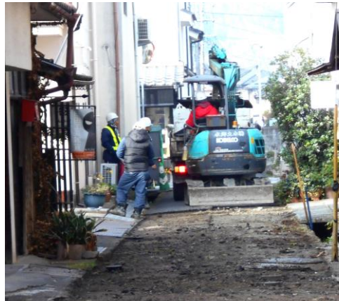
12月10日には舗装を剥ぐ工事を行う
