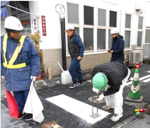
止まれの白線を引く作業員
