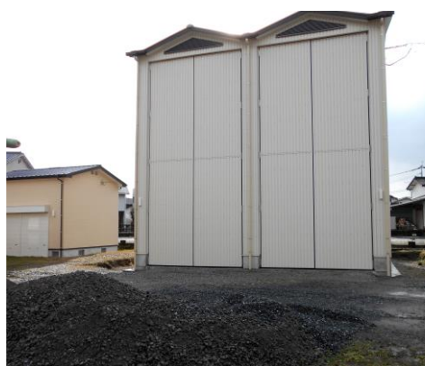
収納庫を囲む土地の外構部分について舗装や側溝整備が行われます
