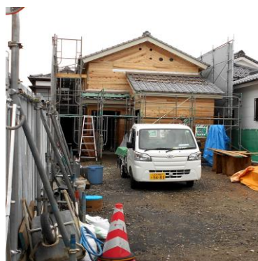
トイレと広場の整備が進む豆田上町の小公園整備事業
