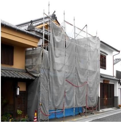
屋根瓦の葺き替えが終わり 2期工事が始まった水田洋家
