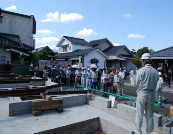
曳き移転工事の工法を聞く参加者
