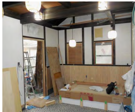
内装工事も併せて行われている旧古賀医院車庫棟の工事
