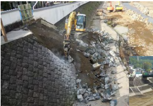
（写真上） 取付け階段の改修工事 御幸橋下流
