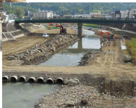
（写真下） 河床の掘削を進める 一新橋と御幸橋の間
