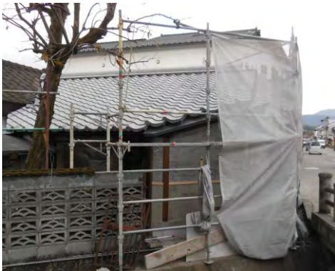
景観に配慮した設計に基づいて、修景される末武家の工事
