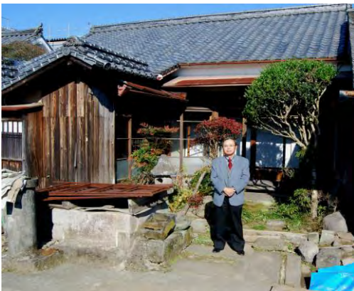
元禄期に建てられた仏間棟の前に、工事概要を語る草野義輔さん
