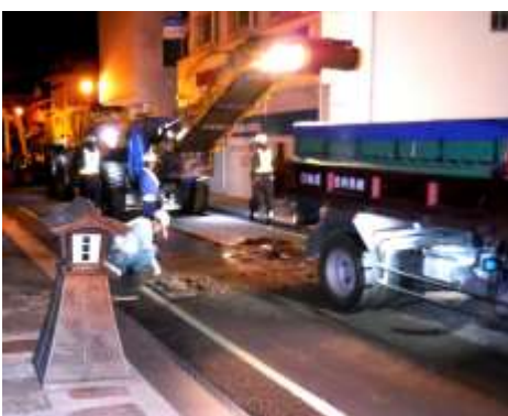
夜間傷んだ舗装を剥がす工事
