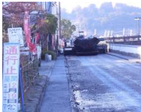
舗装工事が進む豆田西有田線
