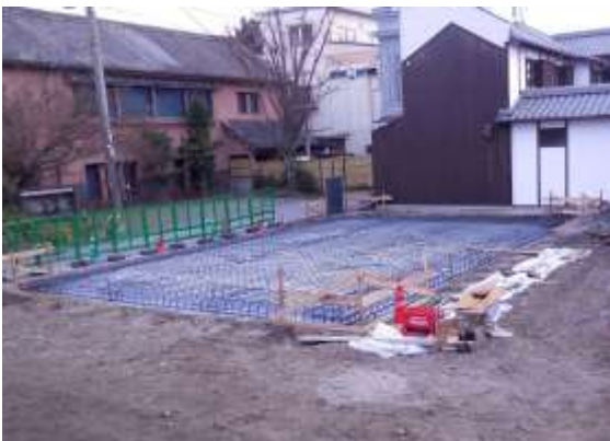
旧船津歯科横に建設される東屋の工事現場
