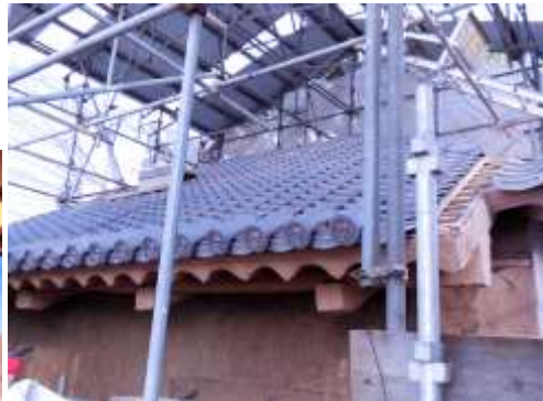
瓦の葺き替えも終了し、土壁の補修を行っている長福寺常灯明堂の工事現場
